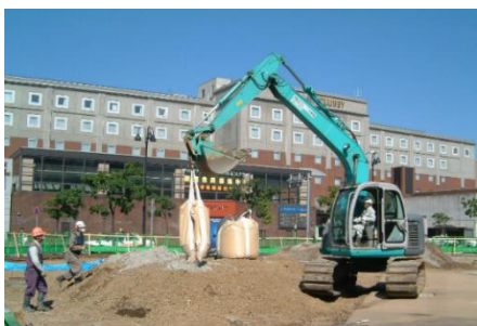
都市部で固化材飛散させずに浅層混合が可能
