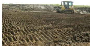
⑤築堤基盤に敷均し
