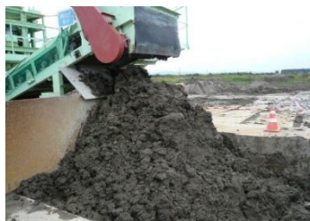
②固化材添加・混合直後
