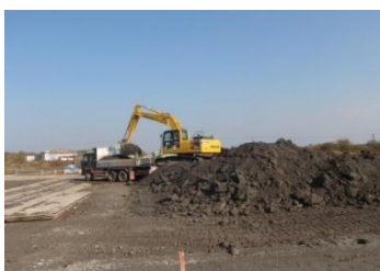
④改良土を解砕し積込運搬
