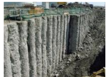
深層混合処理で固化された改良体
