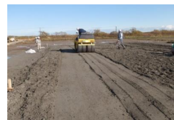
⑥転圧し築堤構築
