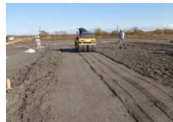
⑥ 転圧し築堤構築
