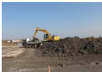
④ 改良土を解砕し積込運搬
