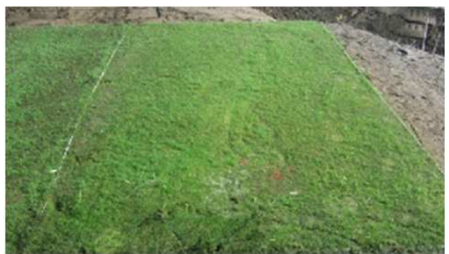
改良土の法面に植生吹付け後、2 ヶ月経過の状態
