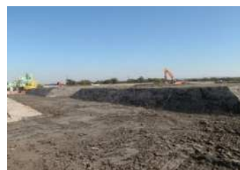
③ 仮養生（ \sigma_7 以上反応させる）
