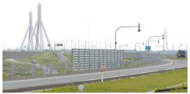
泥炭性軟弱地盤上に整備された高規格道路。 道路盛土の基盤には深層混合処理がなされている。
