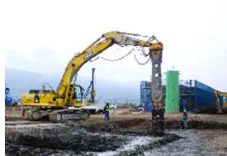
中層混合処理工法
