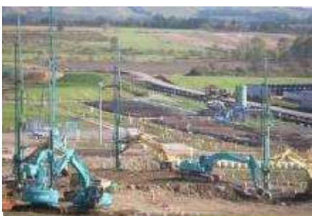
深層混合処理工法
