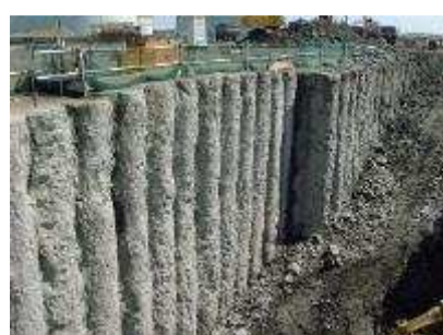
深層混合処理で固化された改良体
