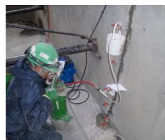
ひび割れ注入状況
