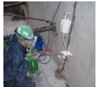
ひび割れ注入状況
