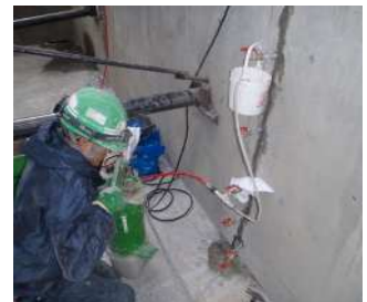
ひび割れ注入状況
