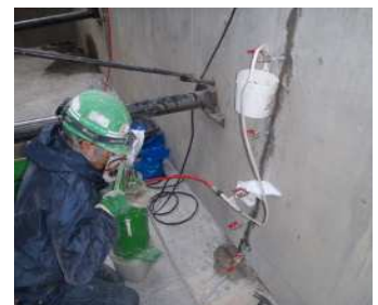
ひび割れ注入状況
