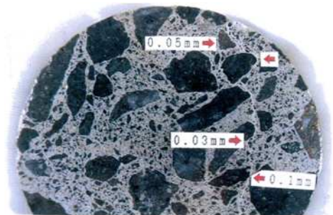
ハイスタッフのひび割れへの注入状況 (写真中の寸法はひび割れ幅です)
